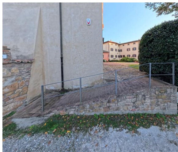
6 rampa laterale Chiesa
